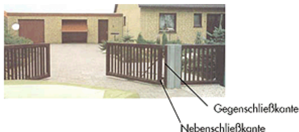
Bild 4: Neben- und Gegenschließkante
